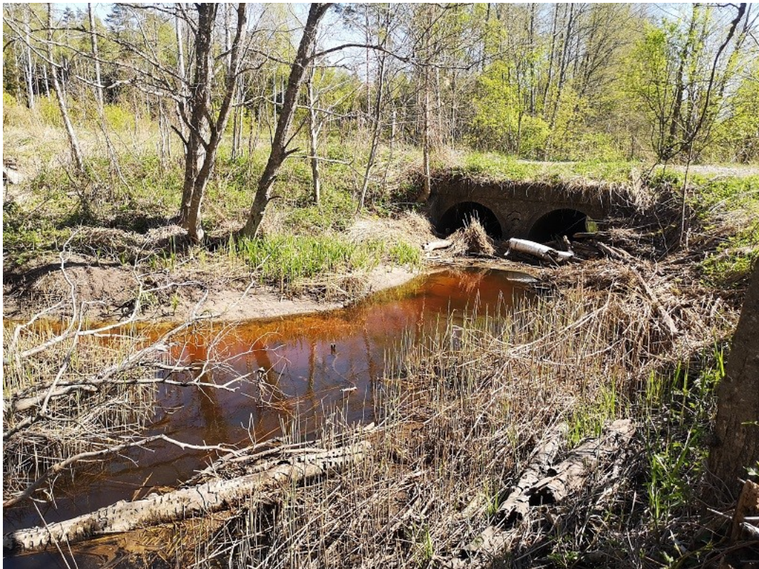
Foto 5. Kaksiktruup Kolga jõel 5,81 km suudmest (Poolnõmme pkr suudmest vahetult allavoolu). Uuendamisel tuleks sellised risu koguvad truubid asendada ovaalse ristlõikega metalltruubiga, mille laius pole oluliselt väiksem jõe voolusängi tavapärasest ristlõikest (R. Järvekülg, 12.05.2023).
